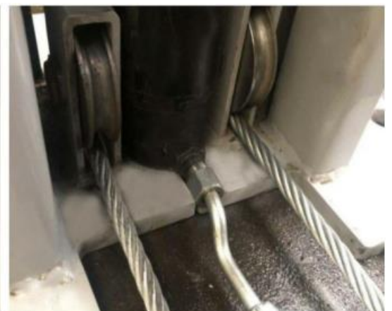
Instalación de tubería Fig10 (primera vez, por favor no apriete los dos lados. No deje que se caiga.)
