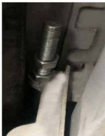
Fig9 Fijar en el agujero y atornillar los equipos, misma instalación de dos lados.
